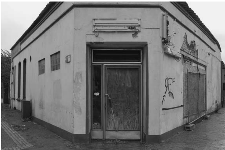
Het overblijfsel van het restaurant van David Hirschberg op de hoek van de Kampstraße en de Pferdemarktstraße. Op dit moment worden er woningen gebouwd.
