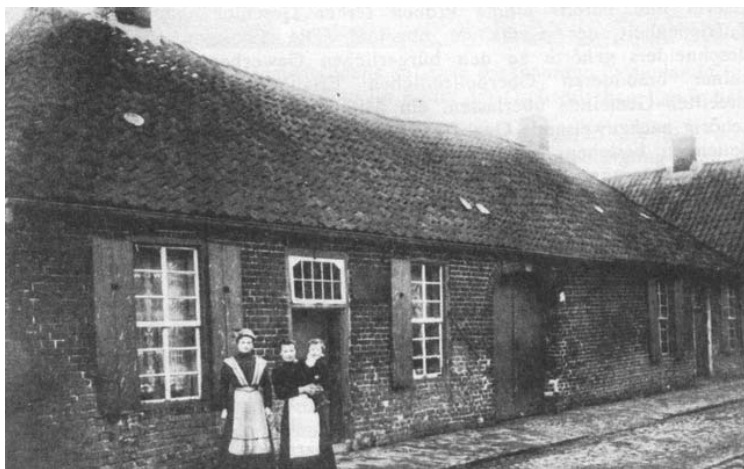
Oude foto van een huis aan de Staustraße in Neustadtgödens waar zich tot 1919 het mikwe van de joodse gemeente bevond. De laatste jaren was het niet meer in gebruik.
