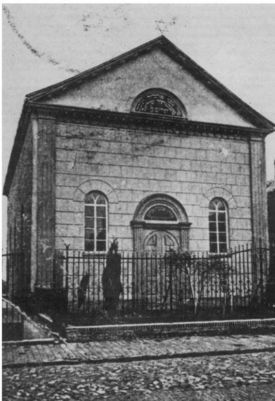
Die Synagoge in Neustadtgödens auf einer alten Aufnahme. Direkt hinter den Türen befand sich die Heilige Arche. Der Fraueneingang befand sich links und der Männereingang an der Rückseite des Gebäudes.
